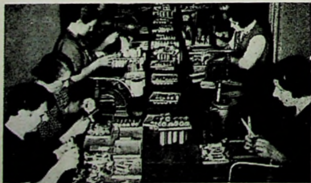
Montage van electro-chemische condensatoren aan de lopende band.
