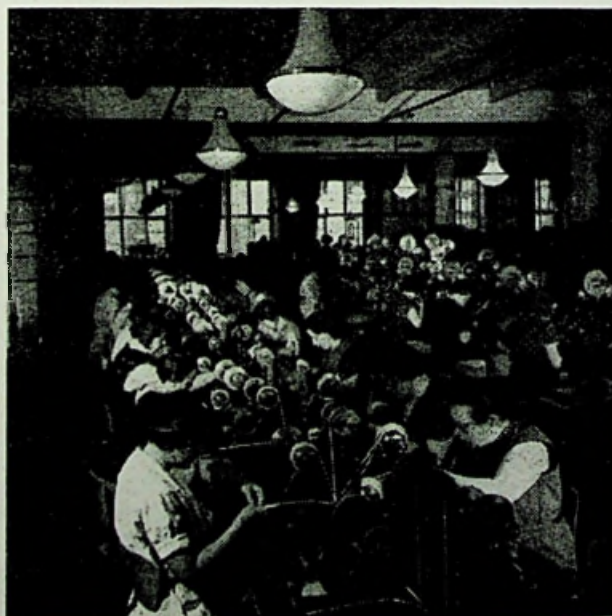
Het wikkelen van alle soorten papiercondensatoren en kunstfoeliecondensatoren.
